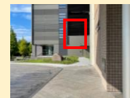
◆エントランスから見たアネックス 夜間通用口
